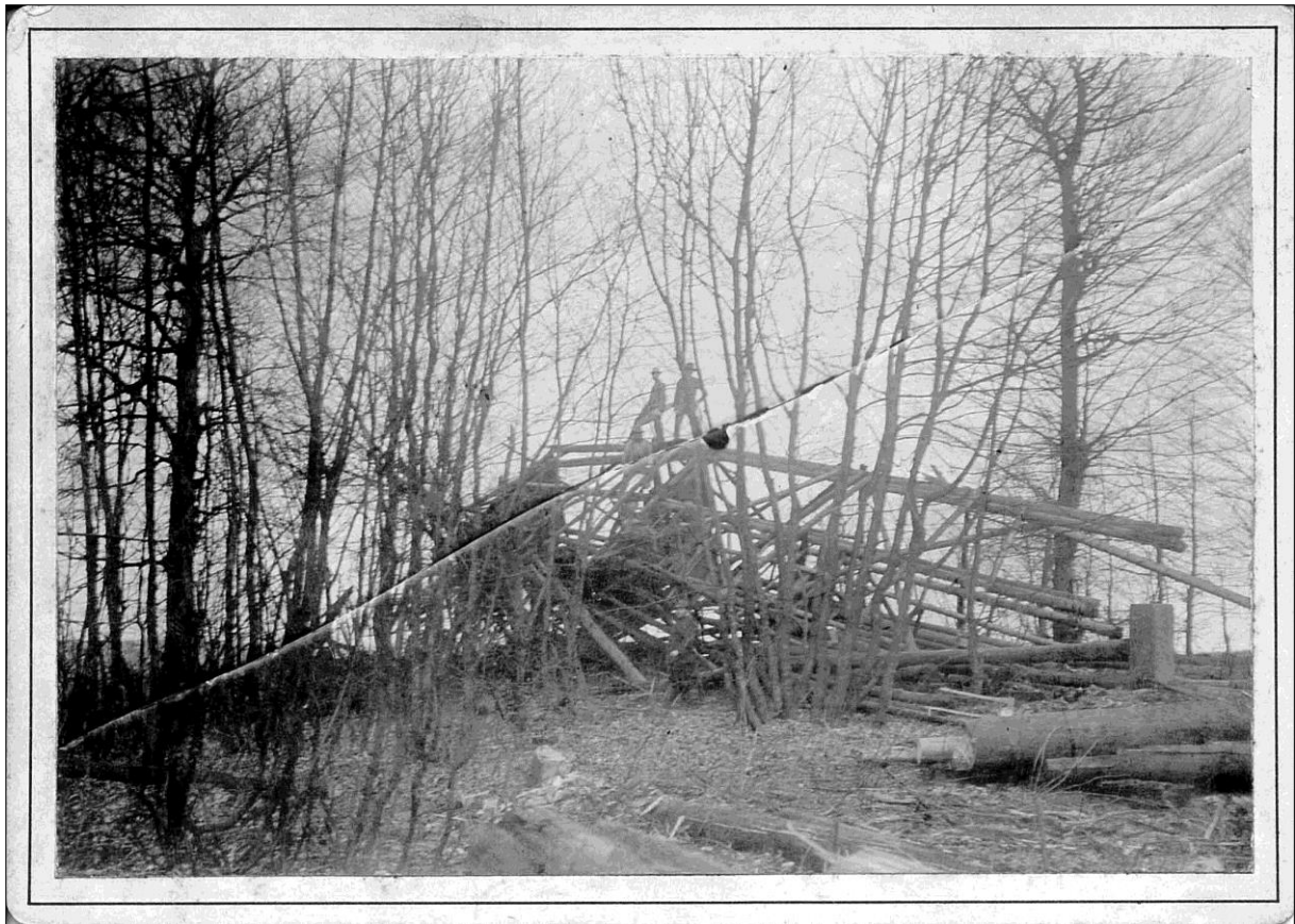
Nach dem Abbruch einer der beiden alten Holztürme auf dem Taufstein.
