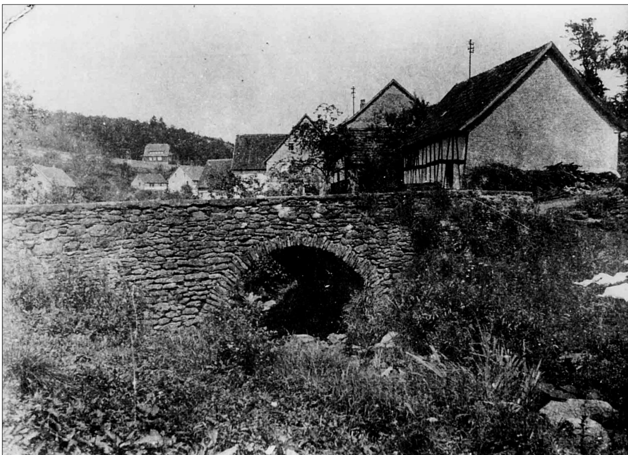
Alte Rundbogenbrücke vor dem Umbau. Dorfansicht, im Hintergrund das Forsthaus Bj. 1924
