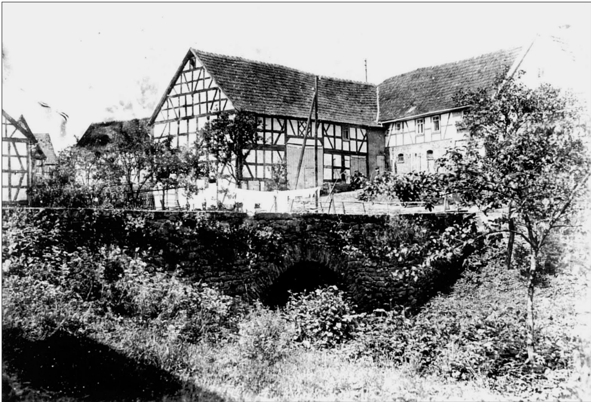
Alte Rundbogenbrücke (Obere Brücke) vor dem Umbau. Dahinter Anwesen des J.C.Hoffmann.
